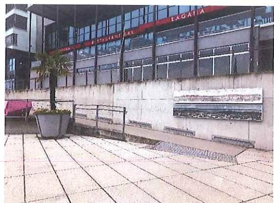
Gegen Abstürze ist die Rampe mittels eines Geländers inklusive Handlauf abgesichert. Lieder nicht zur Gänze, da ein ca. 1,5m langer Teil bis hin zur abgewinkelten Abschrägung fehlt. (siehe Bilder). Speziell für gebrechliche Menschen oder RollstuhlfahrerInnen ist das ein Gefahrenpotential.
