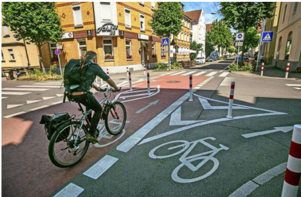
Abbildung 15: Beispiel für Knotenlösung in einer Fahrradstraße – „modaler Filter“, Esslingen, Deutschland (Bildquelle: www.esslinger-zeitung.de, 2022)
