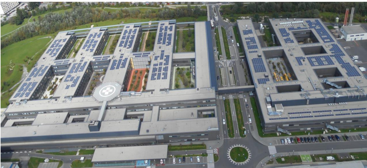
Bild 2: PV Anlage 570 kWp Klinikum Klagenfurt
