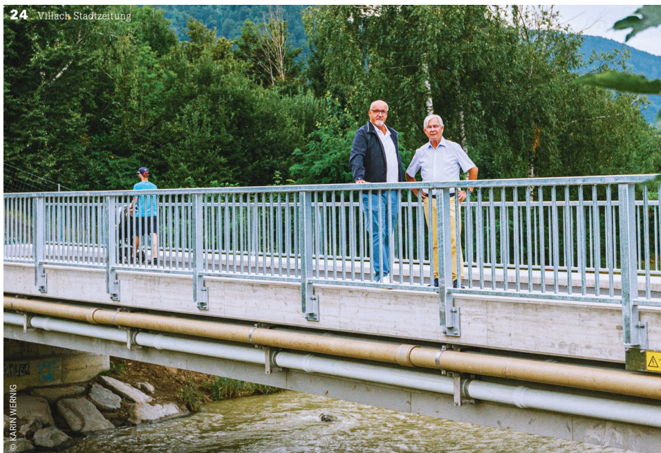
Baureferent Stadtrat Harald Sobe und Treffens Bürgermeister Klaus Glanznig zeigen sich mit der gemeinsamen Sanierung der Brücke über den Treffner Bach zufrieden.
