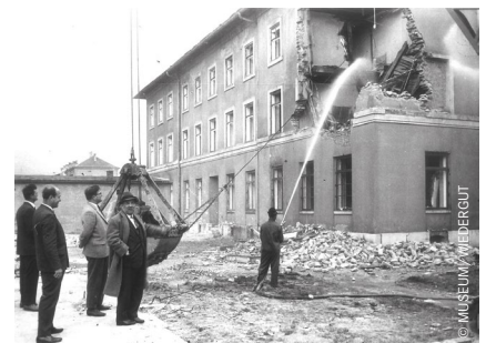
Bürgermeister Timmerer und Baureferent Mörtl beobachten die Abbrucharbeiten.
