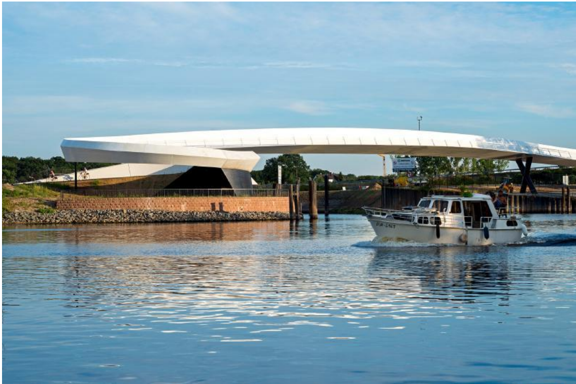
Abbildung 24: Beispiel für barrierefreie Fußgängerbrücke (Geh- und Radweg-Brücke) – Ölhafenbrücke, Raunheim, Deutschland (Quelle: divisare.com, 2014)
