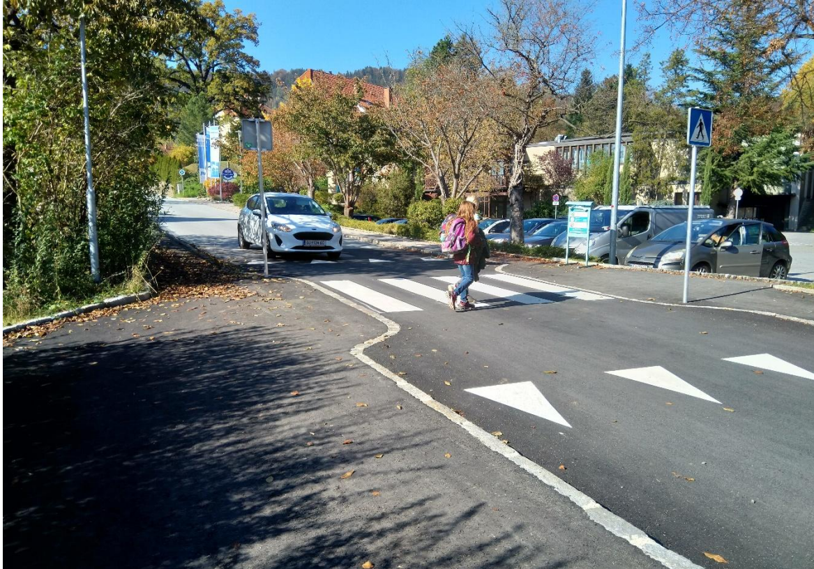
Abbildung 28: Beispiel für Aufwertung der Fußverkehrsinfrastruktur im Ortsgebiet – Gehsteig und sichere Querungsstelle, Frohnleiten, Steiermark (Quelle: verkehrplus, 2022)
