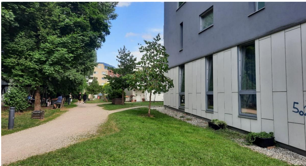
Abbildung 26: Beispiel für Quartiers-interne Durchwegung für den Fußverkehr, Lehen, Stadt Salzburg (Quelle: verkehrplus, 2023)
